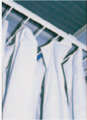
Fig. 16 Le groupe est implanté dans un local fermé : le moteur comporte un excentrique qui fait vibrer le support métallique des manches filtrantes
