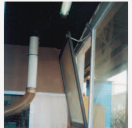
Fig. 19 La prise d'air est réalisée tout simplement en ouvrant une fenêtre directement dans la cabine
